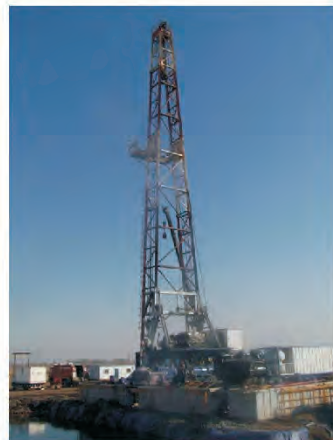
试验现场高耸的井架
